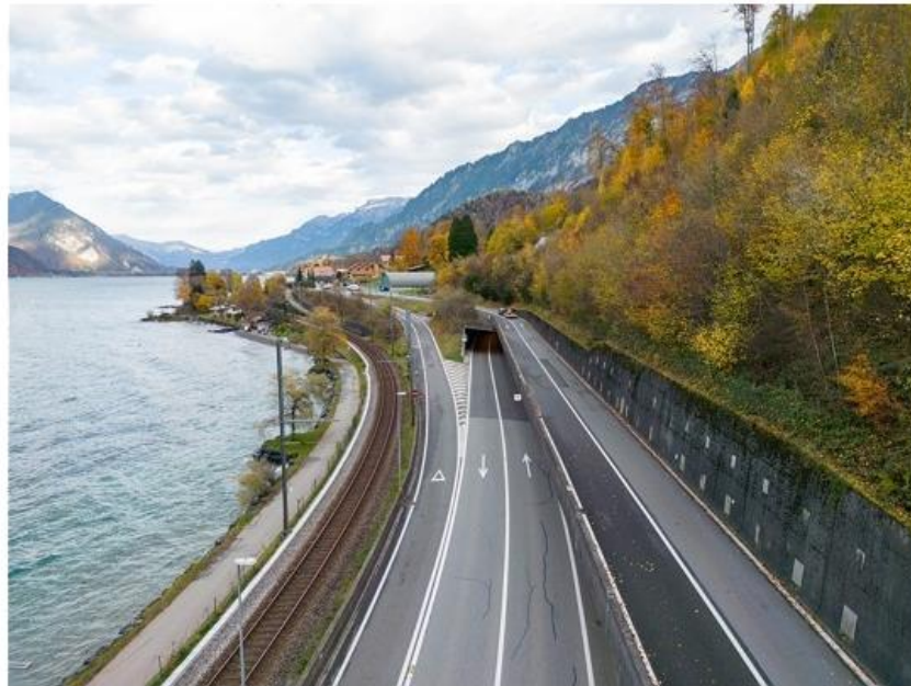
Auf der A1 und A2 finden mehrere Tunnelreinigungen und Wartungsarbeiten statt. Oben ein Bild des Leissigentunnels.
