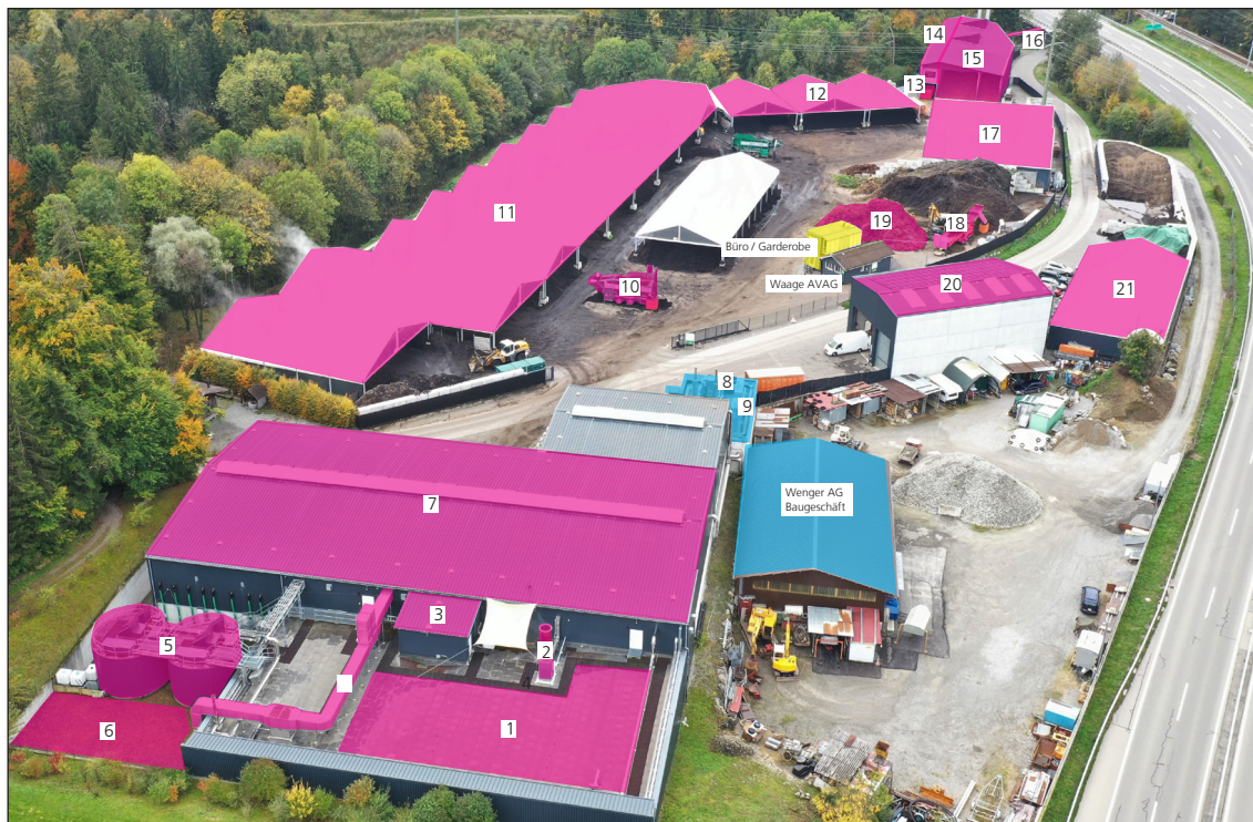
Fig. 5: Übersicht der Anlagen und Bestandteile des bestehenden Betriebes (Ansicht in Richtung Südwesten). [1] Halle mit Fermenterboxen, [2] Gasfackel, [5] Perkolattanks, [6] Biofilter, [7] Vergärungshalle, [8] Transformator, [9] BHKW, [10] Siebanlage, [11] Hochmieten für Kompostreifung, [12] Lager Fertigkompost, [14] Altholz- und Restholzheizung, [17] Brennstofflager, [18] Schredder, [19] Anlieferplatz, [20] Werkstatt und [21] Lagerzelt. Mittig im Bild die das Areal querende Betonstrasse. Auf der Halle mit den Fermenterboxen steht heute ein Gasspeicher.
