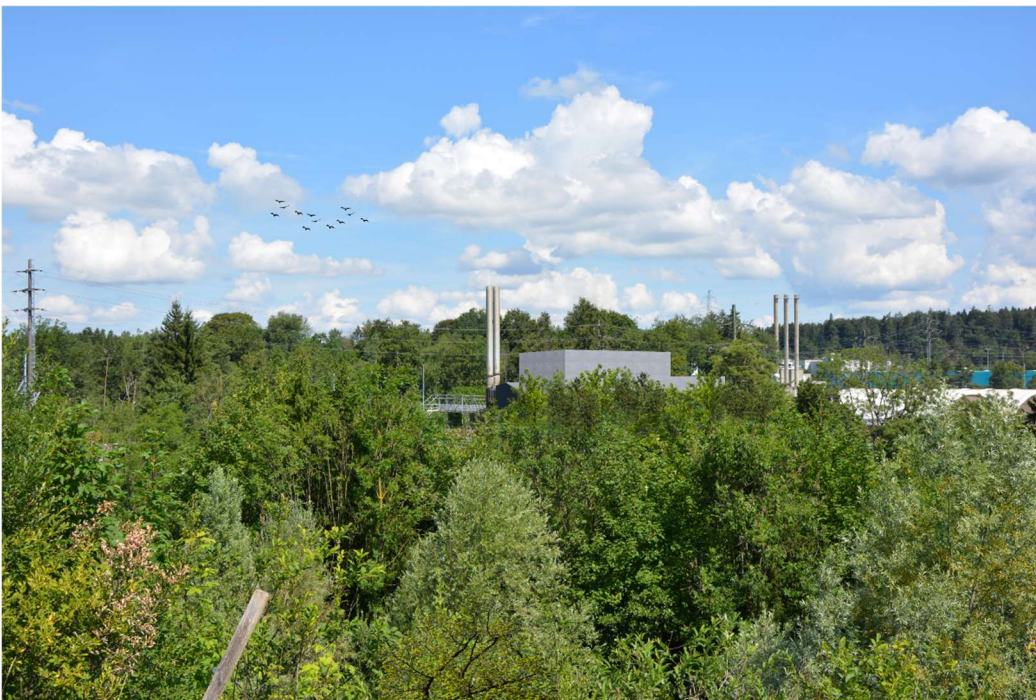
Bild 10: Ansicht Südostfassade aus Position Flurweg, linksufrig der Kander gemäss obiger Karte (gelber Pfeil)
