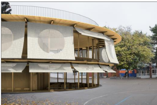
2020 Hortgebäude, Schlieren Switzerland 850 m 2
