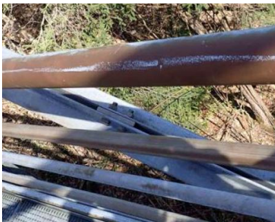
Abbildung 3: Korrodierte Geländerholme
