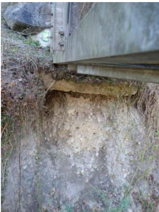
Abbildung 1: Ausgebrochener Untergrund im Widerlagerbereich (Bild und Skizze)
