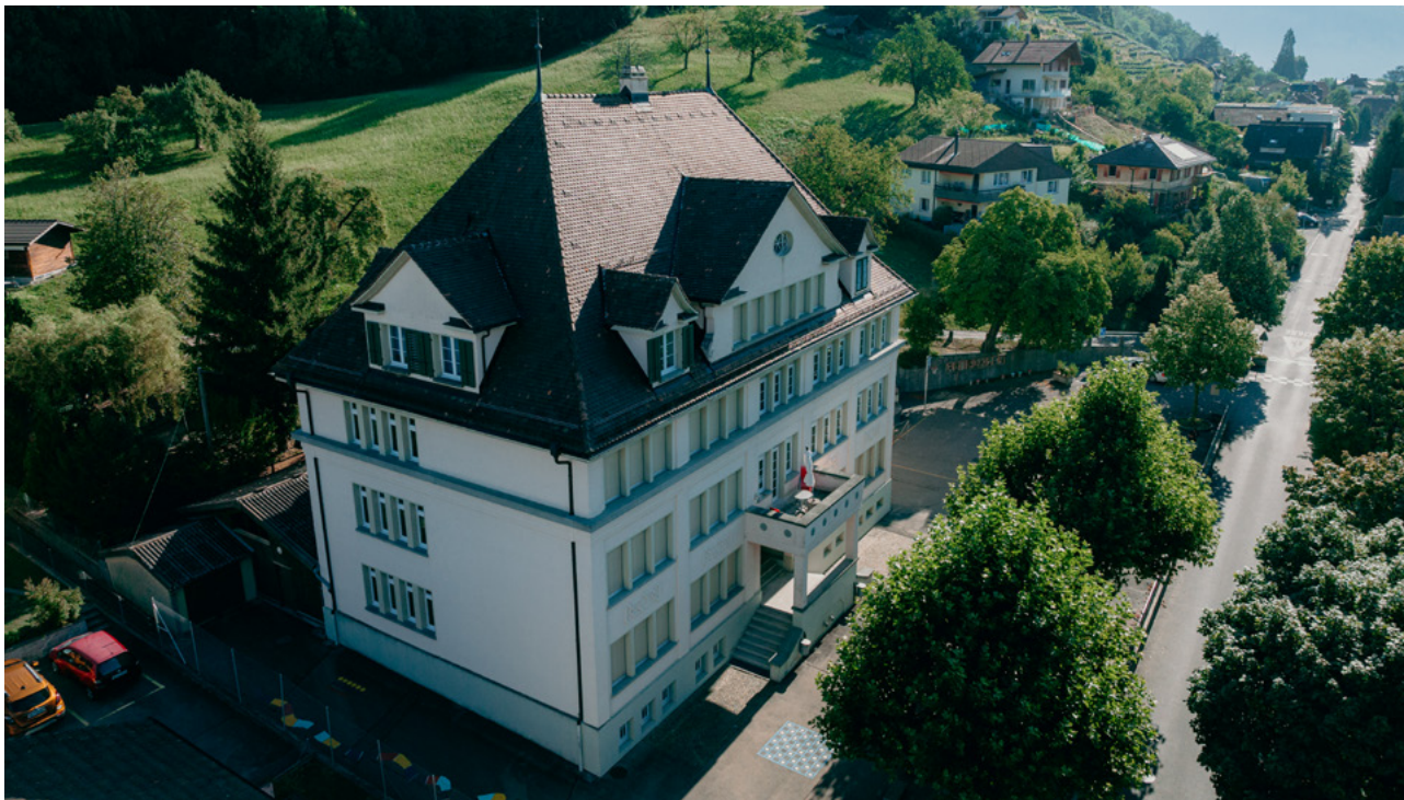
Das bestehende Schulhaus Spiezmoos.
