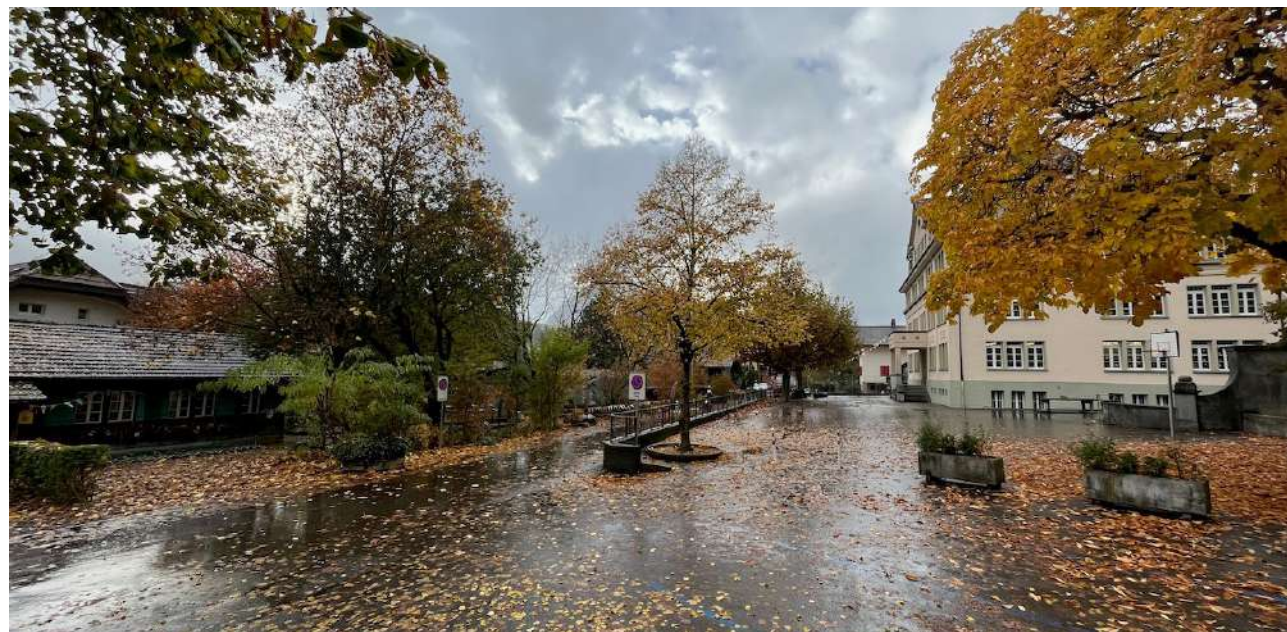
Die Schulanlage Spiezmoos mit dem Schulhaus aus dem Jahr 1924 und den Baracken.
