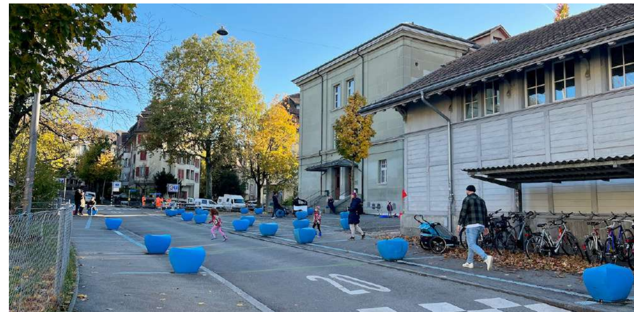
Schule Breitenrain in Bern mit integrierter Quartierstrasse.
