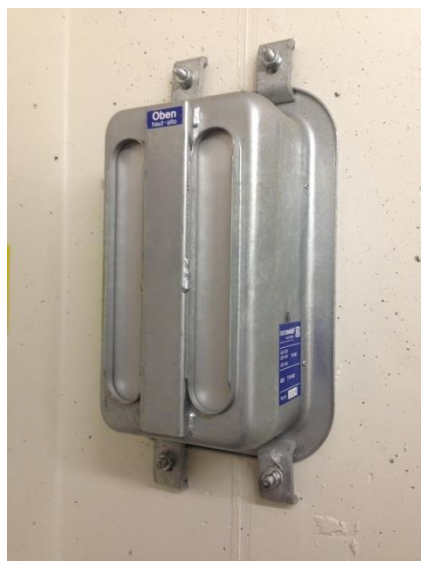
Überdruck-Ventil (UeV)
