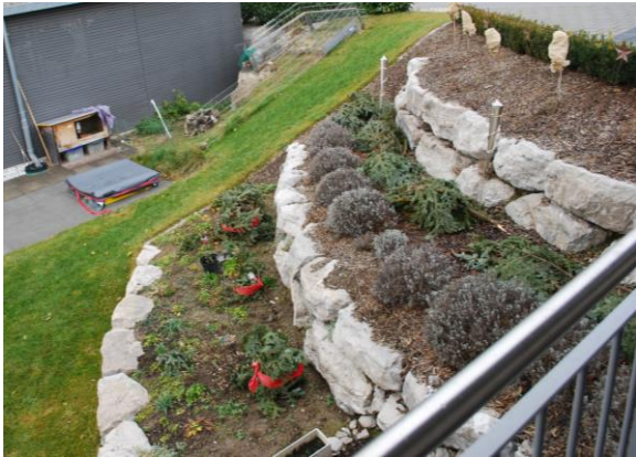
Terrassierung einer Böschung mit Blocksteinen
