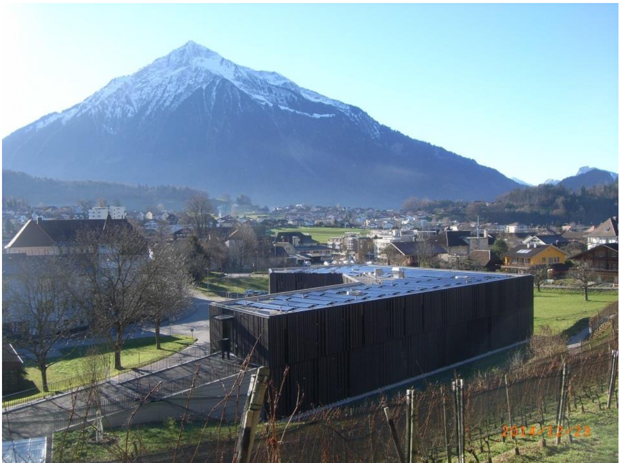
Fotovoltaikanlage auf dem Neubau der Bibliothek in Spiez.
