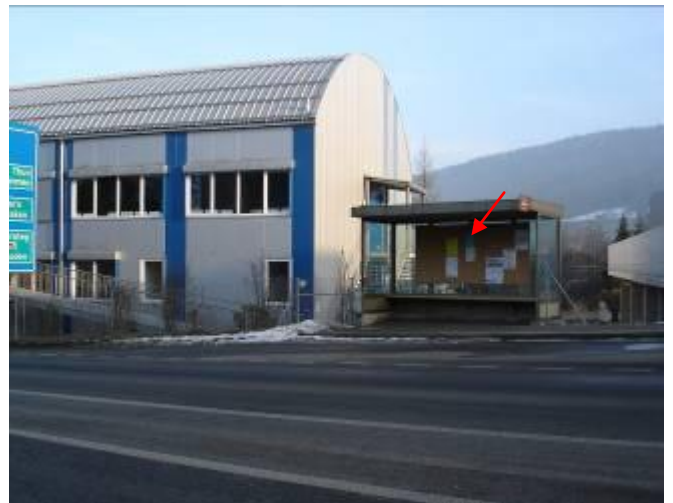
Simmentalstrasse, in Bushaltestelle bei Passarelle
