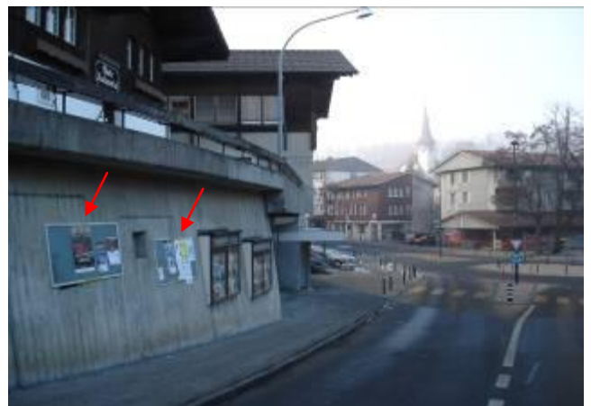
Seestrasse, Kronenplatz, an Stützmauer
