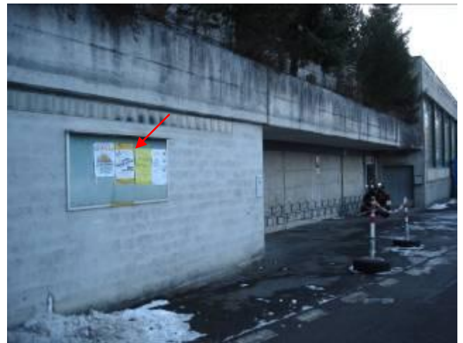
Höhenstrasse, an Mauer beim Schulhaus Roggern
