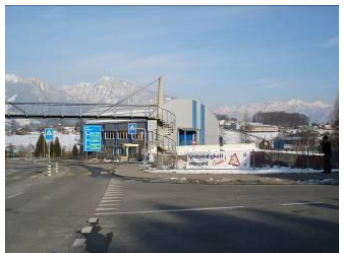
Spiezwiler Simmentalstrasse, Einmündung Faulenbachweg
