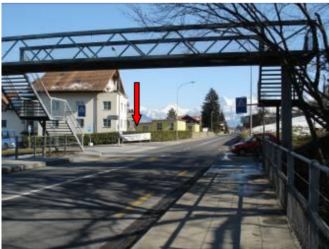
Einigen nach Passarelle bei Einmündung in Werkstrasse
