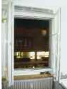
Stosslüftung – nur wenige Minuten lang
