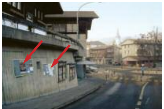
Seestrasse, Kronenplatz, an Stützmauer
