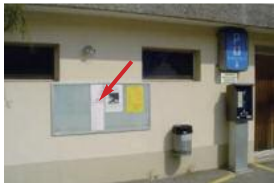
Parkplatz Dorf (Tenne), am Gebäude Pumpwerk neben Ticketautomat
