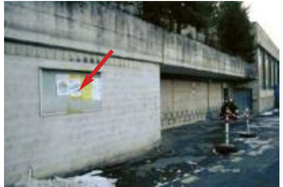
Höhenstrasse, an Mauer beim Schulhaus Roggern
