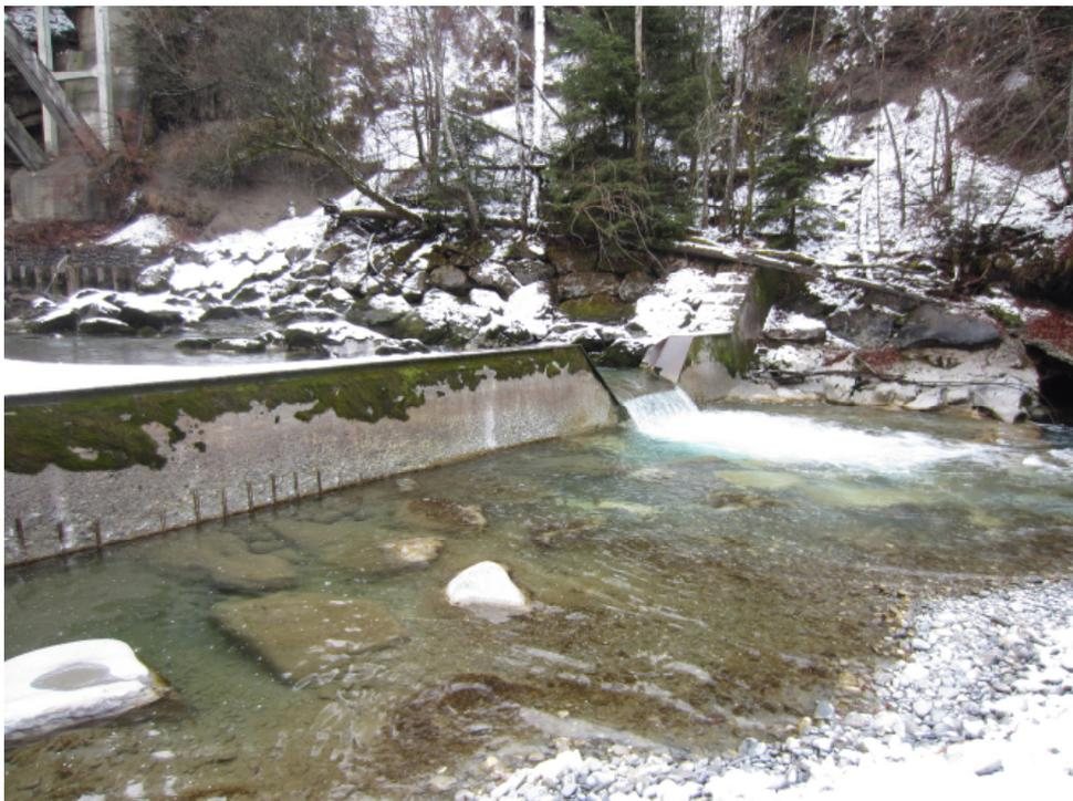
*Abbildung 8: Armierung der obersten Schwelle freigelegt und Ufersicherung unterstrom links teilweise zerstört (07.02.2017)*
