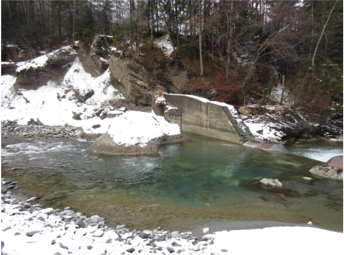
Abbildung 2: Erodierte Einbindung der zweitobersten Schwelle - Gefahr der Umströmung (K+Z AG, 07.02.2017)
