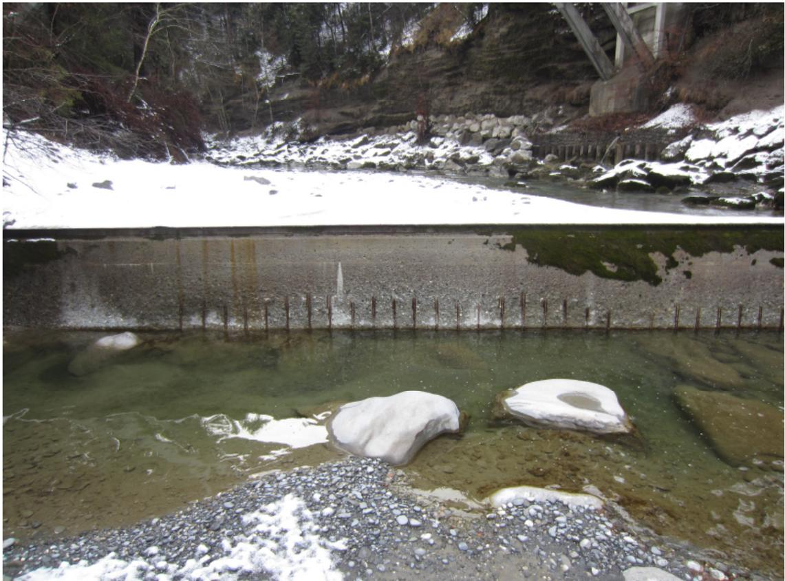
Abbildung 1: Freigelegte Armierung der obersten Schwelle durch Abrasion (K+Z AG, 07.02.2017)
