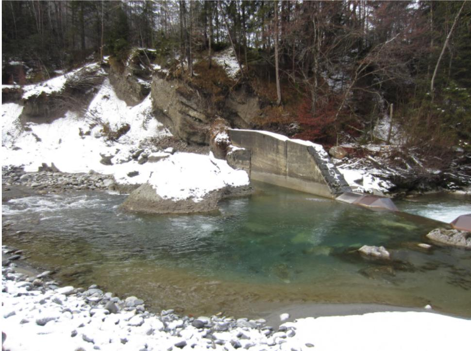
*Abbildung 7: Linkes Ufer stark erodiert sowie Sperrenflügel (KM 3847) freigelegt und durch Umspülung bei Hochwasser gefährdet (07.02.2017)*
