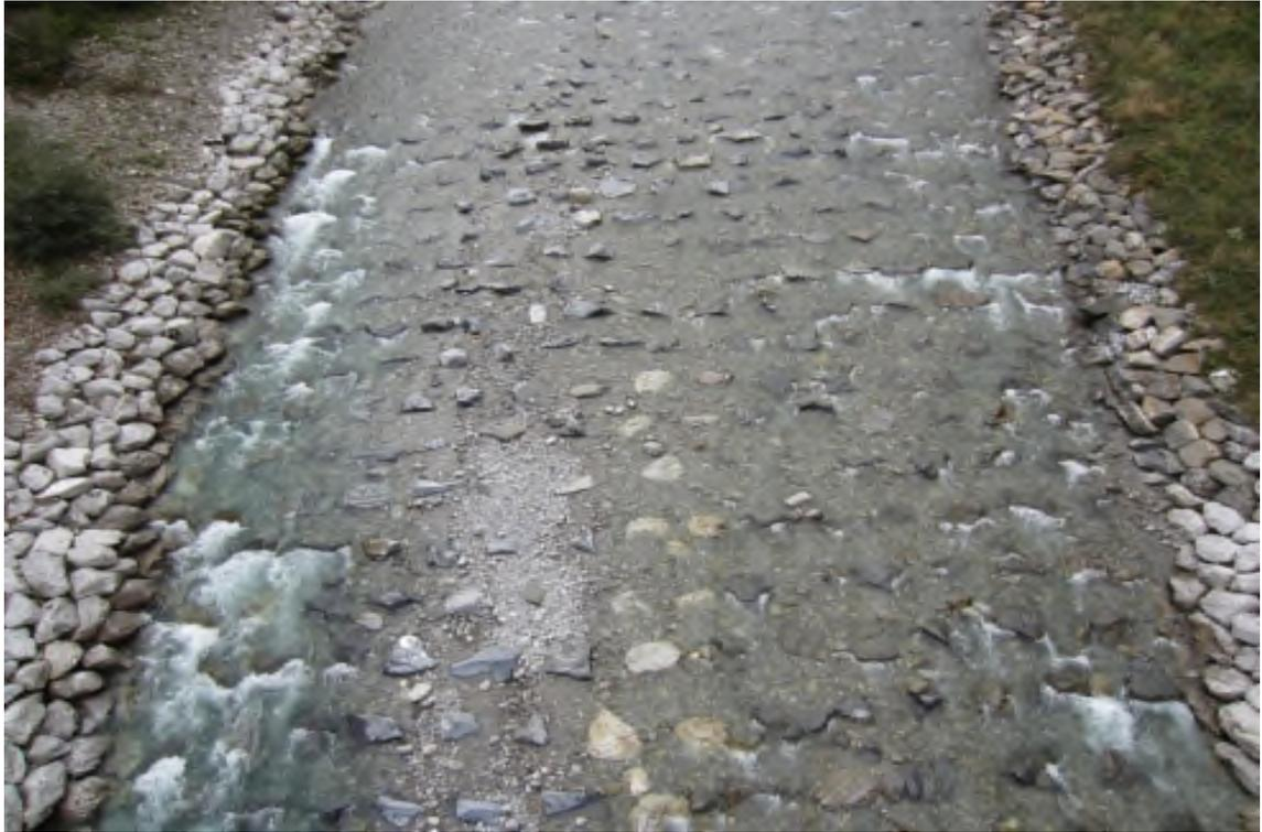
*Abbildung 29: Aufgelöste Blockrampe an der Simme mit Niederwasserrinne am rechten Ufer (22.10.2013)*
