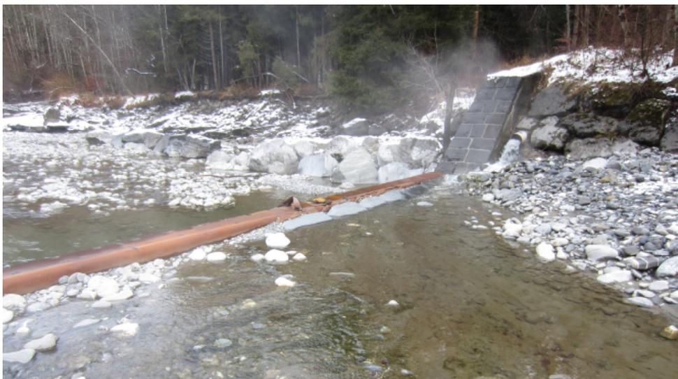
Abbildung 6: Rechtes Ufer unterhalb der Schwelle bei KM 3847 sowie Anprallschutz zerstört (07.02.2017)
