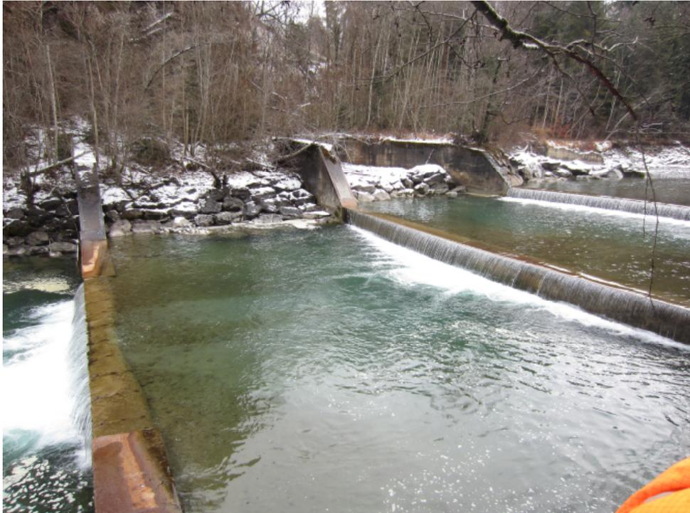
Abbildung 5: Ansicht der Schwellen am unteren Ende des Projektperimeters. Zerstörte Stahlabdeckung und hinterspülte Blocksätze (07.02.2017)
